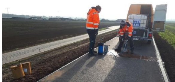
Abbildung 4 - Kronenkontrollweg: Qualitätssicherung durch Bohrkernentnahme der Asphaltschichten (11/2020)
