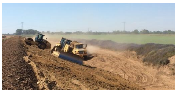
Abbildung 3 - Wasserseitige Deichböschung: Einbau Schutzschicht auf Tondichtung (06/2019)
